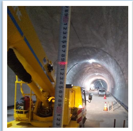
↑ 照明設置予定位置より垂直に降ろしたスケールに当たったレーザー
