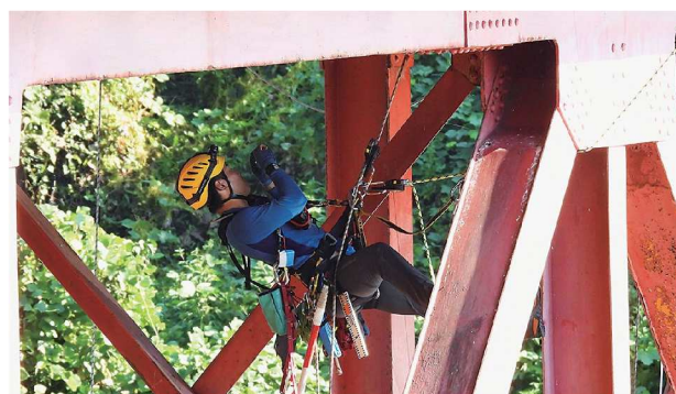
橋梁点検業務（ロープアクセス工法）
