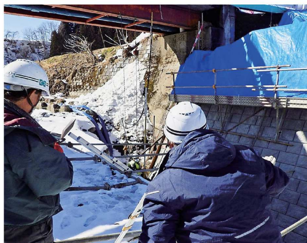
橋梁架替工事 (積算・現場管理業務)
