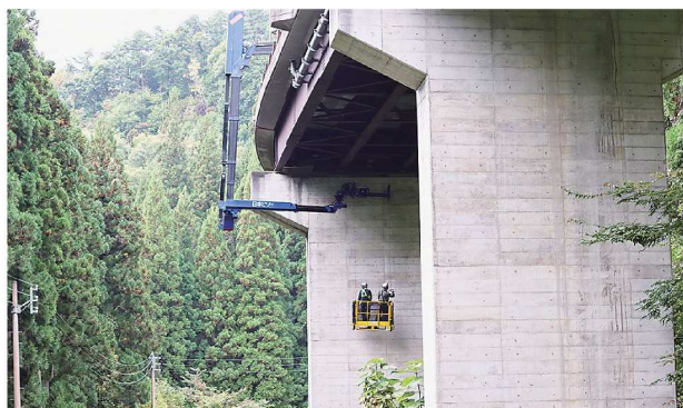
橋梁点検業務（ゴンドラ車による点検）
