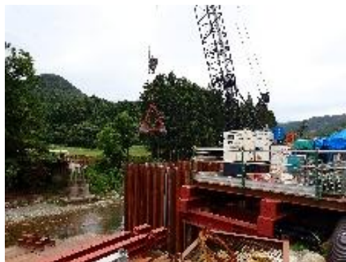
相馬市茄子小田橋災害復旧工事（設計・積算・工事管理）
