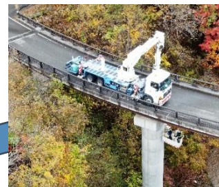
飯館村堰堤橋点検業務
