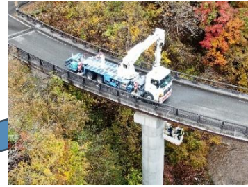
飯館村堰堤橋点検業務
