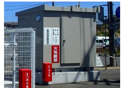
須賀川地方広域消防組合非常用電源設備工事 (設計・積算・工事管理)
