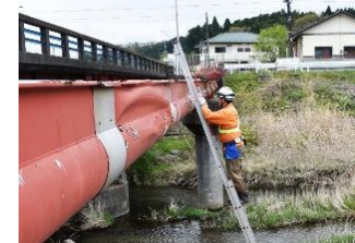
富岡町水管橋点検業務
