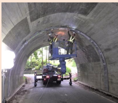
点検状況(全景)
