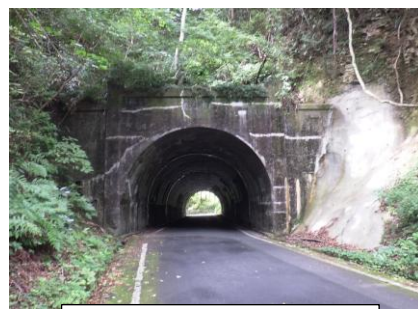
トンネル正面(起点側)
