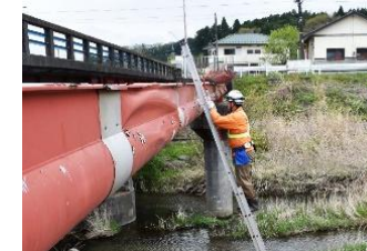
富岡町水管橋点検業務
