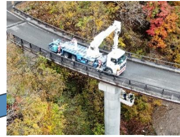
飯舘村堰堤橋点検業務
