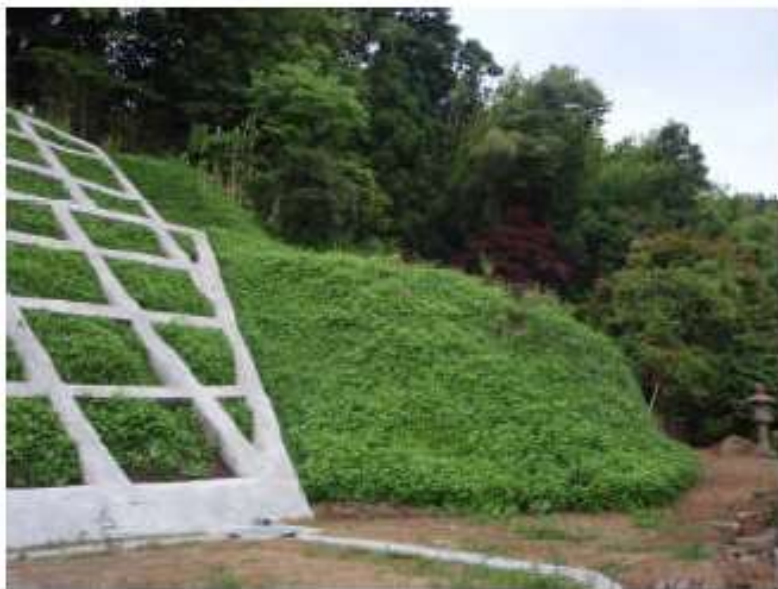
植生基材吹付工
