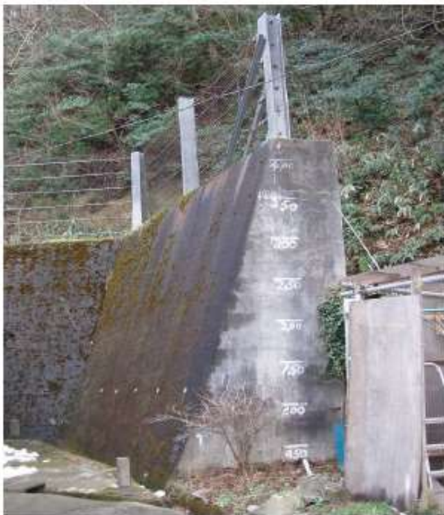
重力式擁壁工
