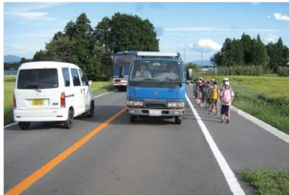
幅走路肩による歩行空間確保事例 （本宮土湯温泉線）
