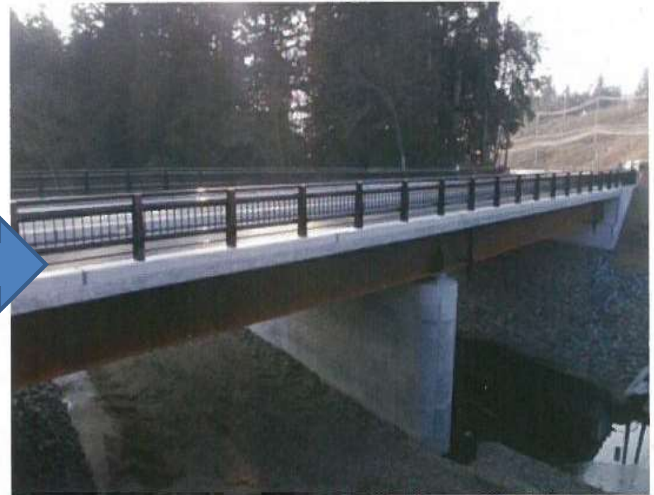
整備後（25t 車両対応）
