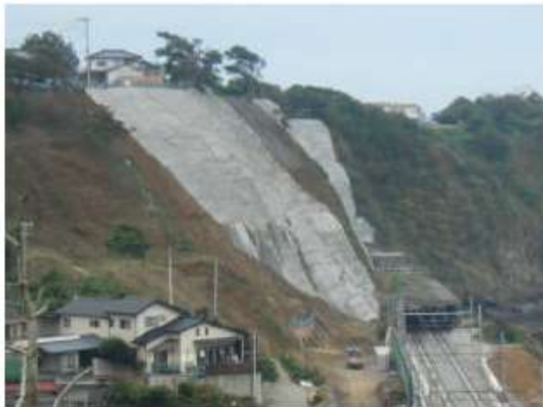
モルタル吹付工
