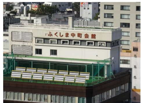
設備設置後のイメージ
