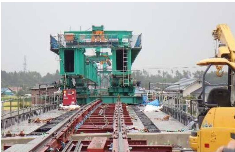
現場状況は、右岸(橋台)側上部に高圧送電線があり、架設時の離隔を考慮し二組桁架設(抱込み式)が実施されております。
