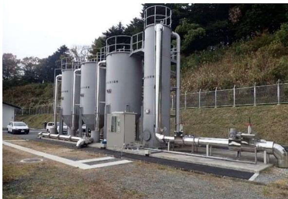
(竣工後:原水に含まれる懸濁物質を除去するために設置した前処理ろ過設備)
